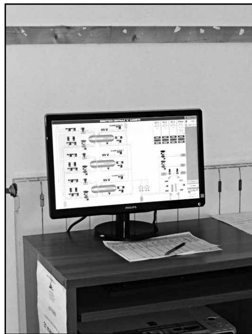
Al piano terra degli uffici comunali e a vista del cittadino che si rechi all'anagrafe, è in funzione il "cervello" del teleriscaldamento. Si tratta di un computer con uno speciale programma che consente agli operatori di monitorare in ogni istante il funzionamento dell'impianto, dalle centrali alla rete di distribuzione. E' così possibile apportare correzioni ai valori prefissati e avviare tutti gli interventi necessari in caso di funzionamento anomalo o di emergenze.
